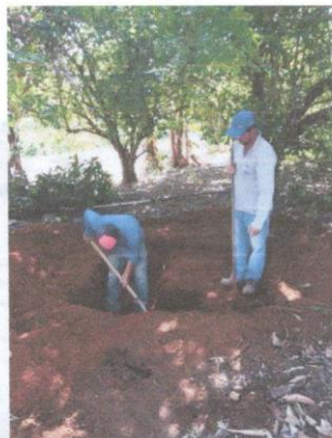
Imagem 8. Fossa Séptica sendo instalada
