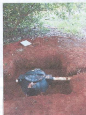
Imagem 9. Fossa Séptica instalada corretamente
